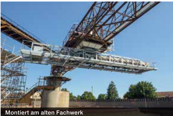
Montiert am alten Fachwerk
