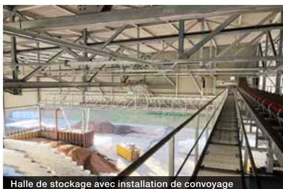
Halle de stockage avec installation de convoyage
