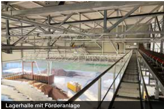
Lagerhalle mit Förderanlage
