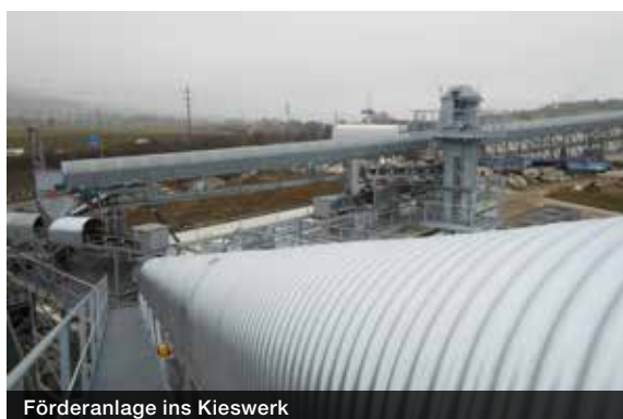
Förderanlage ins Kieswerk
