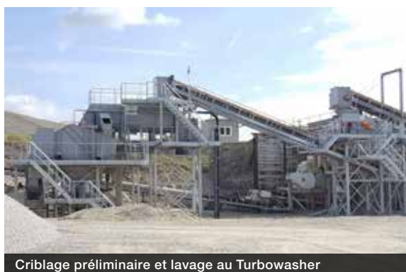
Criblage préliminaire et lavage au Turbowasher
