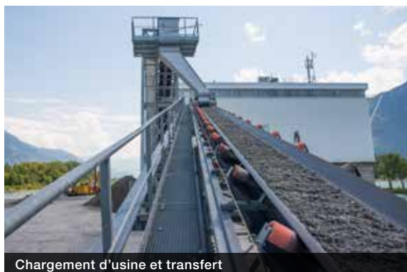
Chargement d'usine et transfert
