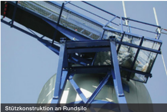
Stützkonstruktion an Rundsilo
