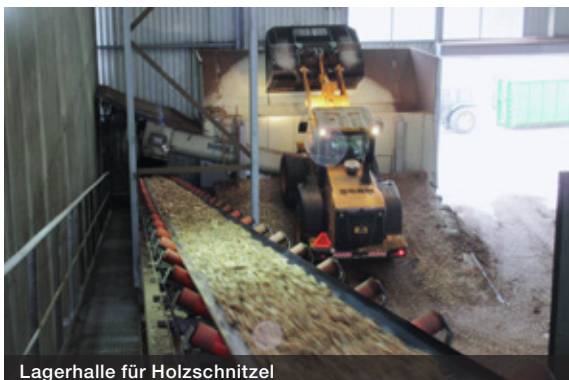
Lagerhalle für Holzschnitzel
