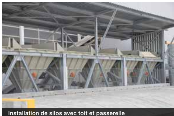
Installation de silos avec toit et passerelle
