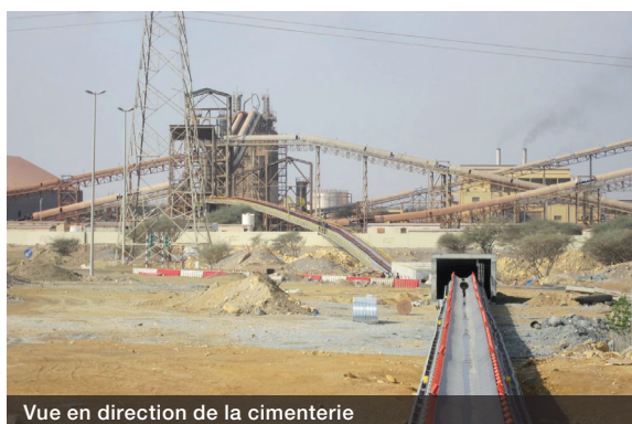
Vue en direction de la cimenterie
