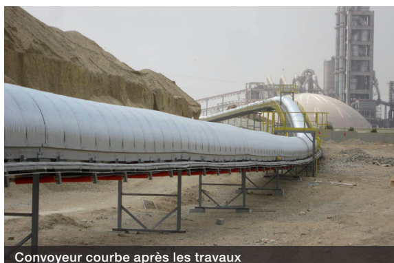
Convoyeur courbe après les travaux
