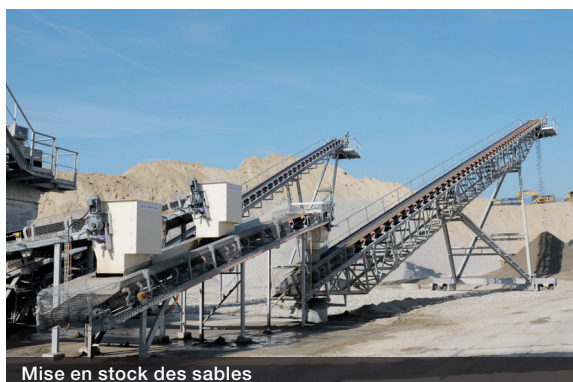
Mise en stock des sables
