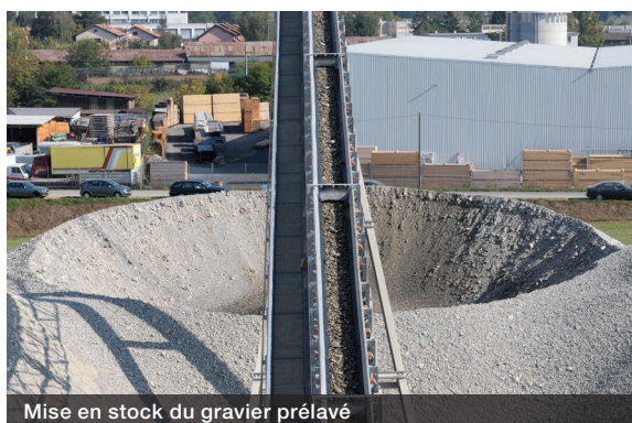
Mise en stock du gravier prélavé
