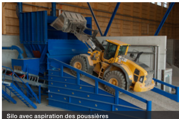
Silo avec aspiration des poussières
