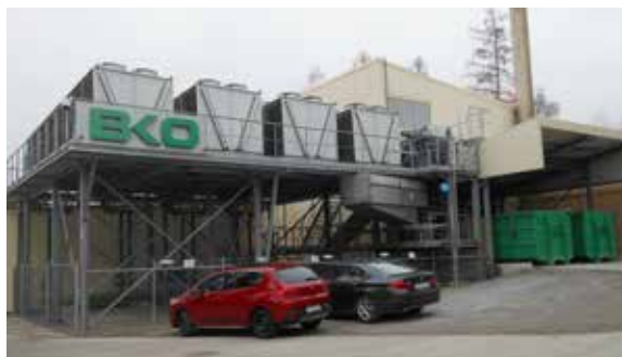
Construction en acier pour le refroidisseur, bennes d'élimination
