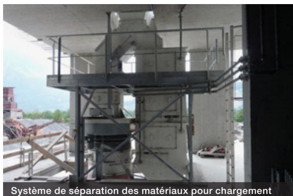
Système de séparation des matériaux pour chargement
