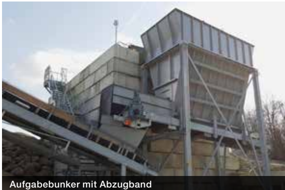
Aufgabebunker mit Abzugband
