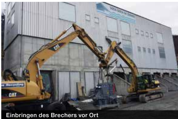
Einbringen des Brechers vor Ort
