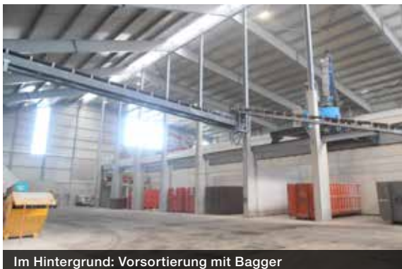
Im Hintergrund: Vorsortierung mit Bagger
