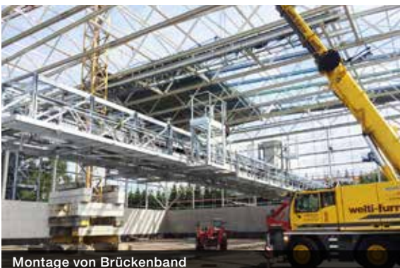
Montage von Brückenband
