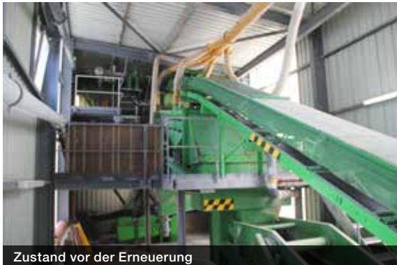
Zustand vor der Erneuerung
