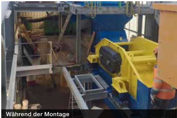
Während der Montage
