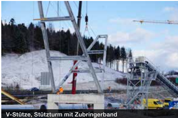
V-Stütze, Stützturm mit Zubringerband
