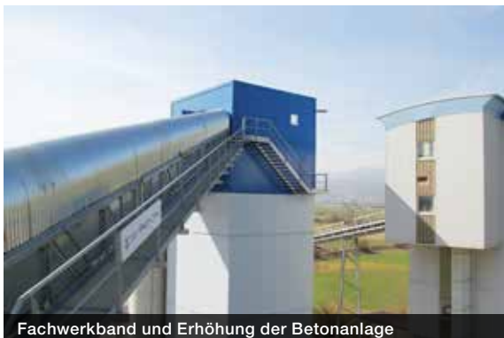
Fachwerkband und Erhöhung der Betonanlage
