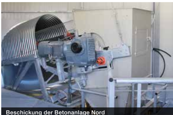
Beschickung der Betonanlage Nord
