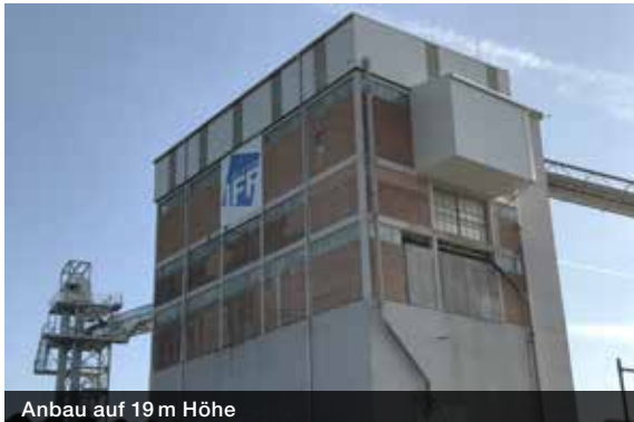
Anbau auf 19 m Höhe
