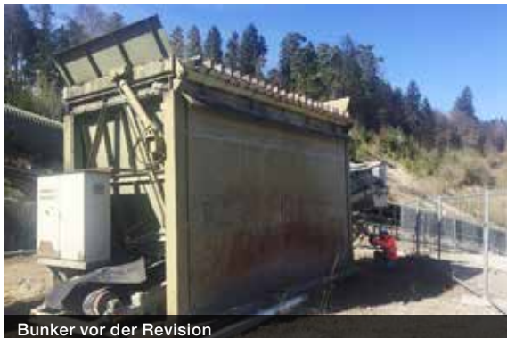
Bunker vor der Revision
