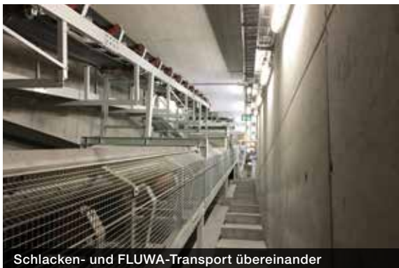
Schlacken- und FLUWA-Transport übereinander
