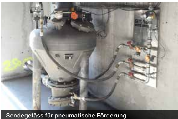
Sendefass für pneumatische Förderung
