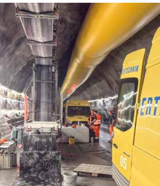
Einsatz für die Bandverlängerung für die Grossbaustelle A2 Zweite Röhre Gotthard.
