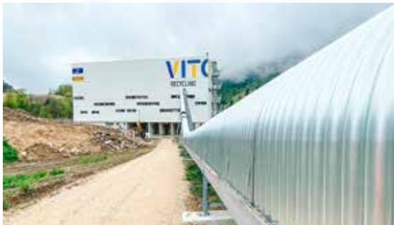
VITO Recycling AG, Péry-La Heutte Soil washing system
