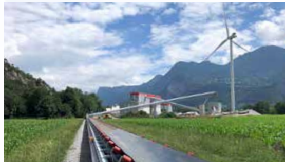
Kieswerk Oldis AG, Haldenstein Processing system
