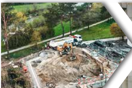
Matériaux d'excavation et de déblai
