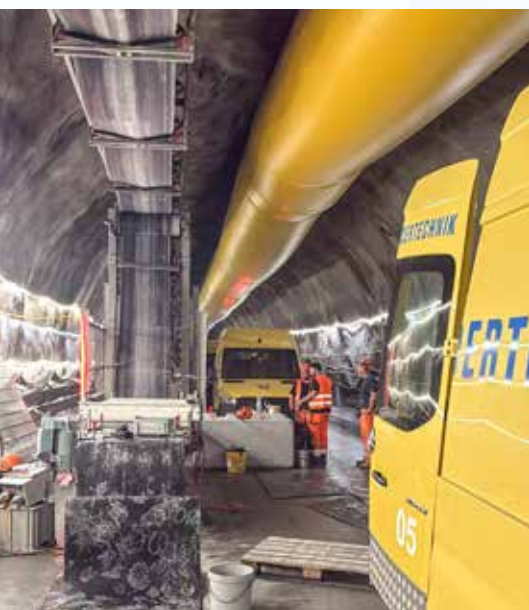
Intervention pour l'extension de la bande sur le grand chantier A2 Second tube du Saint-Gothard.
