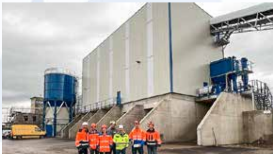
BRT Baustoff Recycling AG, Weinfeldern Nassmechanische Aufbereitungsanlage
