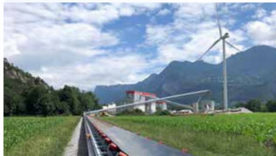
Kieswerk Oldis AG, Haldenstein Aufbereitungsanlage
