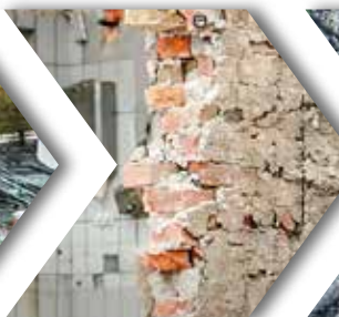
Beton- und Mischabbruchmaterial
