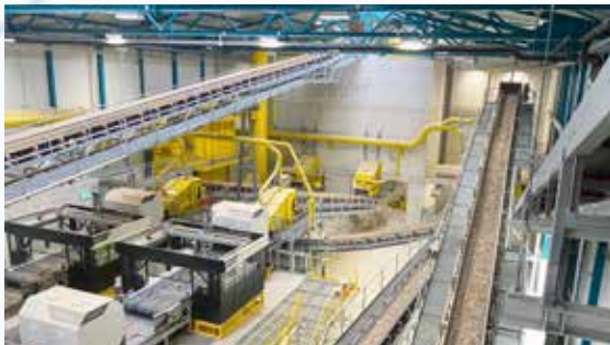
Eberhard Bau AG, Oberglatt Aufbereitungszentrum EbiMIK
