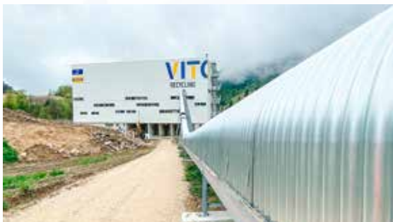
VITO Recycling AG, Péry-La Heutte Bodenwaschanlage
