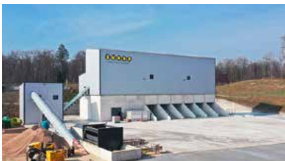
Surer Kipper Transport AG, Pratteln Aushub- und RC-Aufbereitungsanlage
