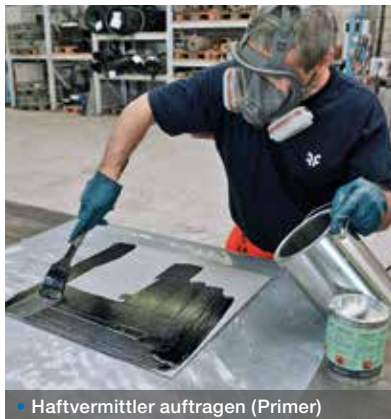
• Haftvermittler auftragen (Primer)
