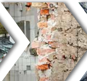
Débris de béton et gravats mixtes
