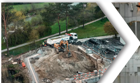
Matériaux d'excavation et de déblai
