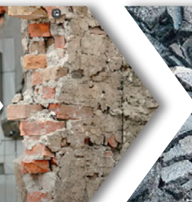
Débris de béton et gravats mixtes
