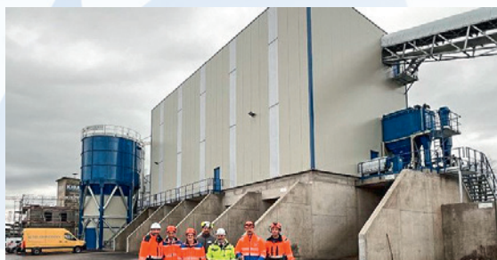
BRT Baustoff Recycling AG, Weinfelden Installation de traitement mécanique par voie humide
