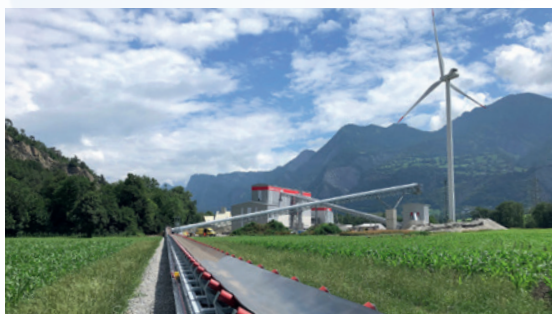
Kieswerk Oldis AG, Haldenstein Installation de traitement
